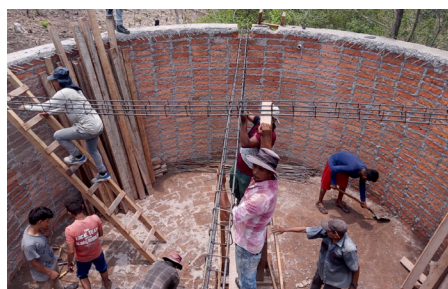
Mitglieder der Gemeinde El Jiote nehmen Reparaturarbeiten an der örtlichen Wasserquelle vor.
